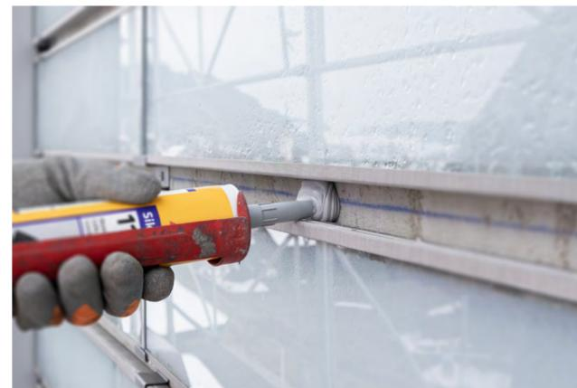
KLEBSTOFF AUFTRAGEN UND LAMELLE EINSETZEN
