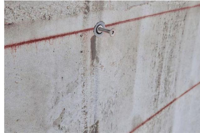
ANZEICHNEN, BOHREN, ANKER SETZEN
