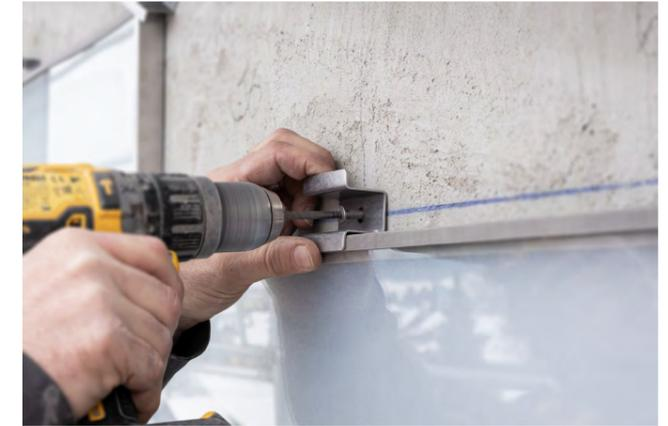
MODULE MIT DEM TRÄGERTEIL BEFESTIGENSETZEN
