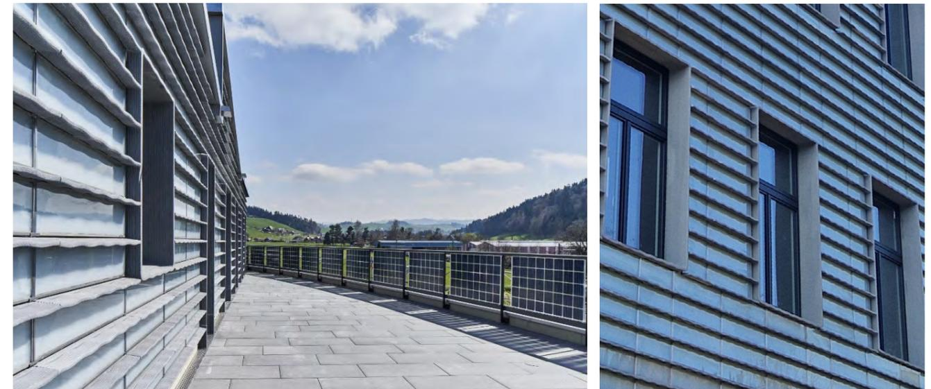
Das eindrucksvolle Produktionsgebäude der Lanz-Anliker AG ist mit einer 1.600m<sup>2</sup> grossen 3D.SOLAR-Fassade ausgestattet. Der Ziegel Monobrick mit einer Wandstärke von 36,5 cm dämmt das Gebäude und dient gleichzeitig als Wärmespeicher für die gewonnene Sonnenwärme. Eine Photovoltaikanlage auf dem Dach sowie auf der Balkonbrüstung produziert mehr als doppelt so viel Strom wie das Gebäude verbraucht.
