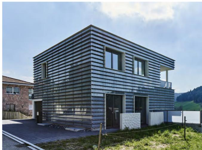
Bei diesem Einfamilienhaus wurden 250m<sup>2</sup> 3D.SOLAR Fassade verbaut. Die Grundmauern wurden mit dem Ziegel Monobrick mit einer Wandstärke von 36,5 cm errichtet. Eine Photovoltaikanlage erzeugt zudem mehr Strom, als das Haus im Jahr verbraucht.
