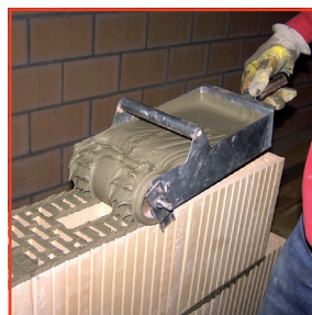
2. Auftragen Dünnbettmörtel
