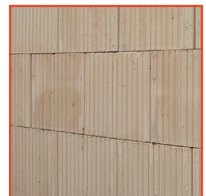
4. Sauberes und mass- genaues Mauerwerk
