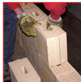
3. Versetzen EcoModul
